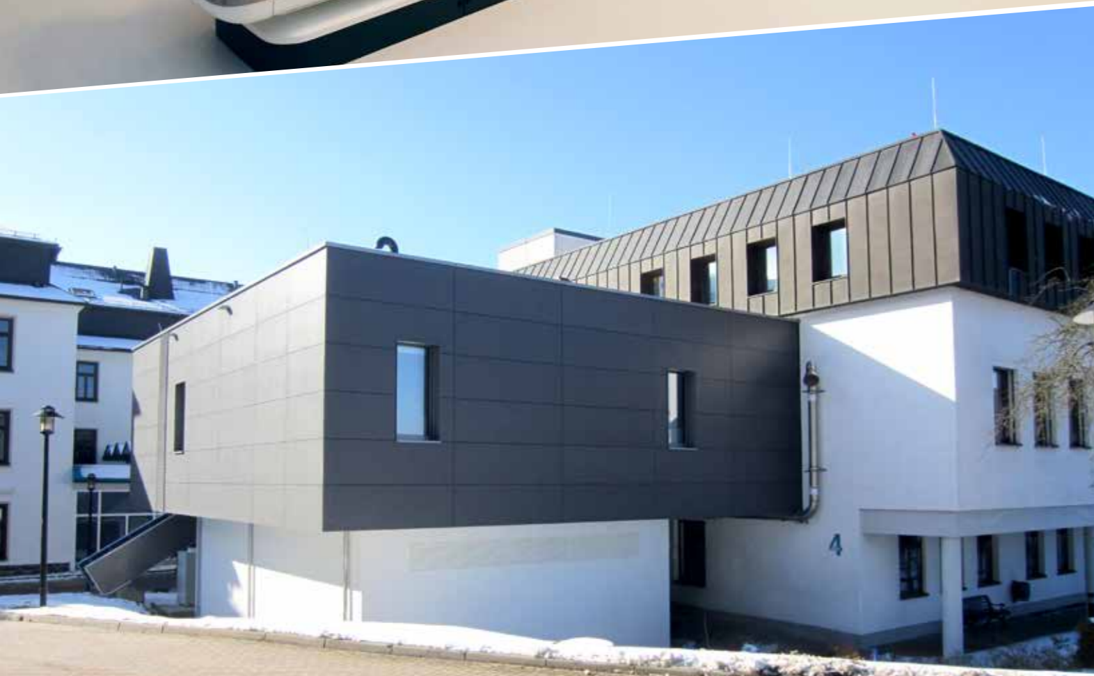
KLINIKUM OBERGÖLTZSCH HYBRID OP RODEWISCH | 2 GESCHOSSE | 6 MODULE | 270 M 2
